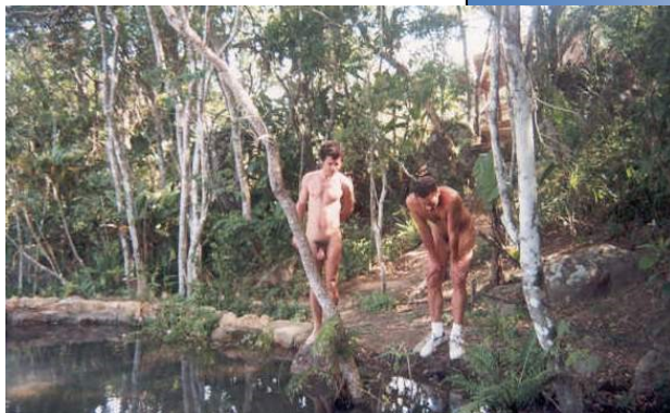
Beto e Celso, conferindo as obras do lagui-nho no riacho de água doce.
